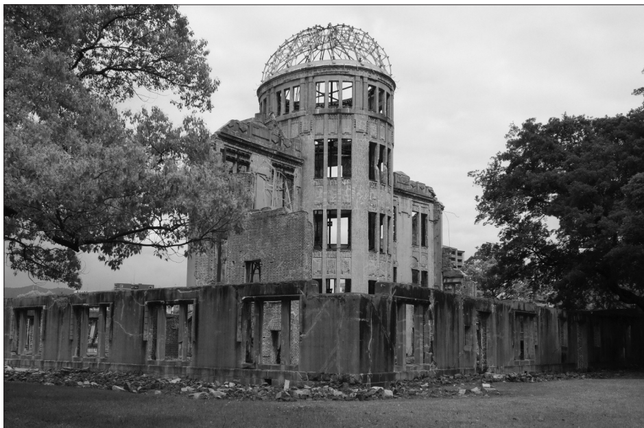
Den eneste bygningen som står igjen etter atombomba i Hiroshima.
