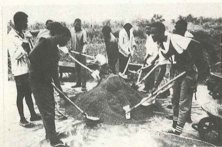
Arbeidet på et administrasjonsbygg for skoleprosjektet i Kongo er allerede i full gang.
